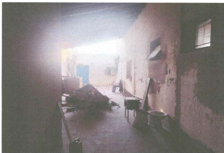
Refeitório lavanderia: preparação das paredes
