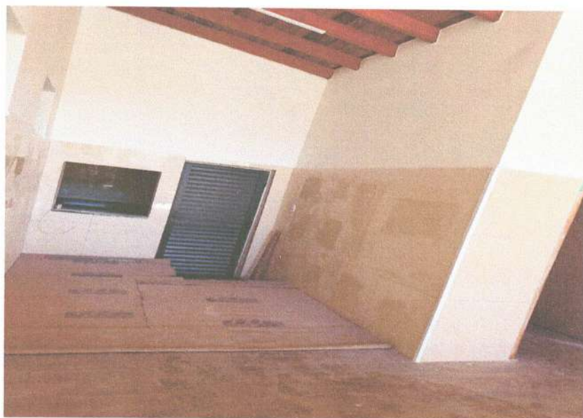
Revestimento 60mt refeitório/varanda
