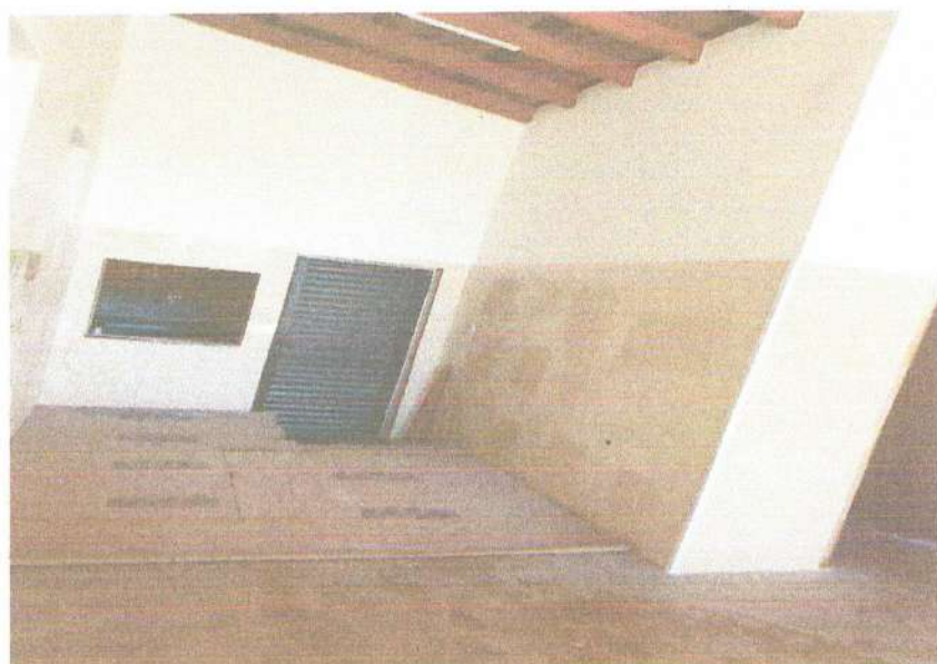
Revestimento 60mt refeitório/varanda
