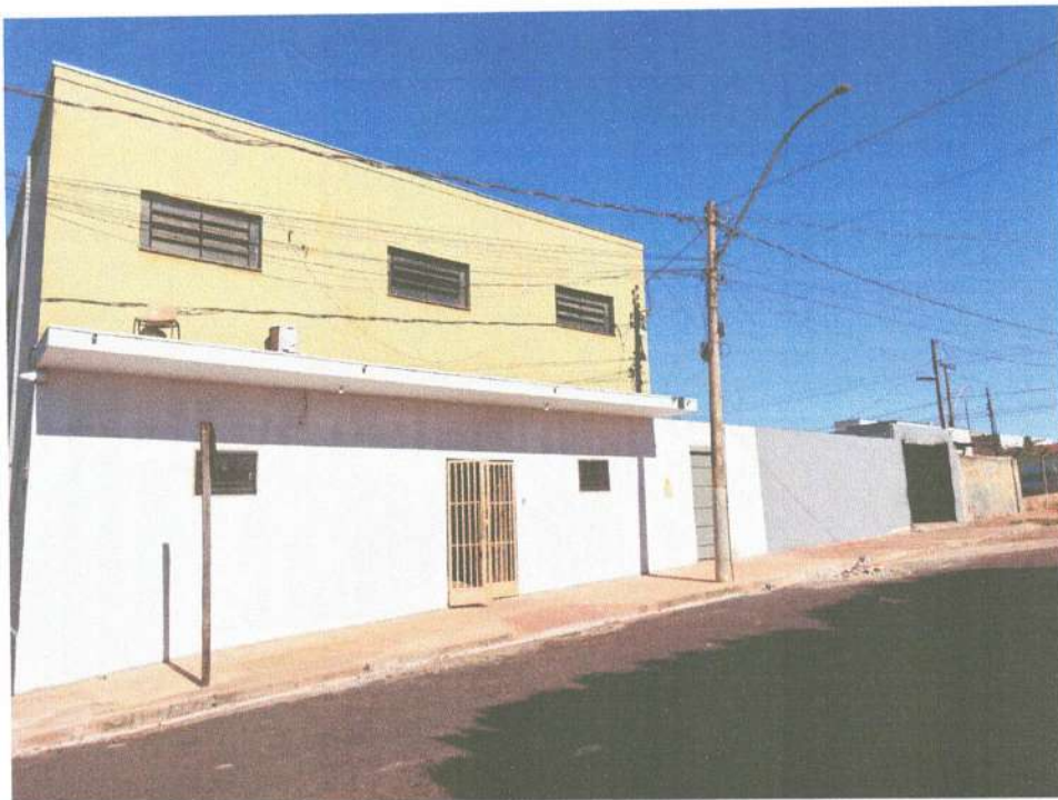
Frente Rua: Parreira Lima
