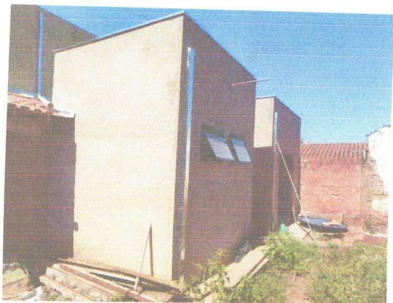
Preparação parede lateral para o quintal
