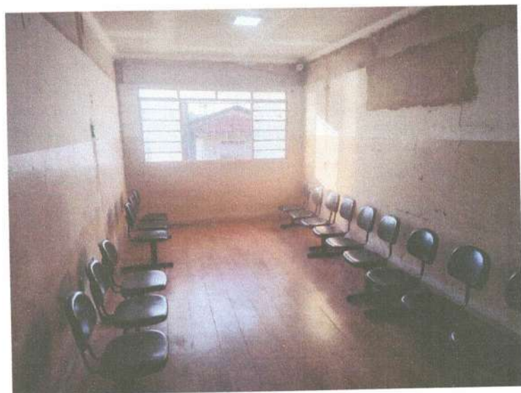
Preparação paredes e teto sala/copa
